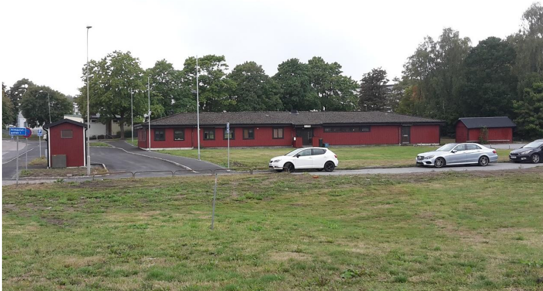
Foto: Klubblokalen inom den västra delen av planområdet. Till vänster syns transformatorstationen.
